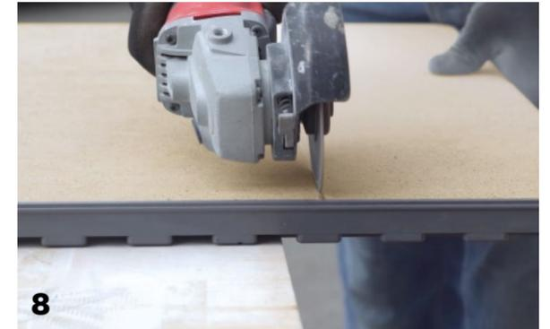
Las placas se pueden cortar con un cortabaldosas o una sierra circular de mano.
