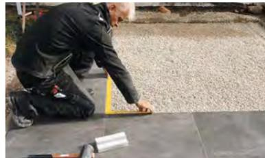
10. Verificar la ortogonalidad de las placas ya colocadas con un goniómetro.
