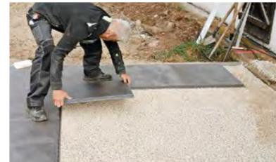
12. A continuación colocar otras placas hacia el interior de la superficie empezando por la esquina derecha.
