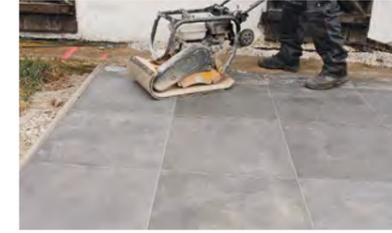
17. Para evitar daños en la superficie y las juntas lávese el pavimento antes de compactarlo.
