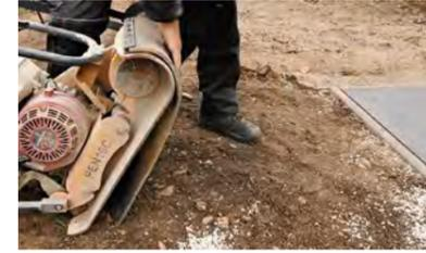
16. Compactar las placas colocadas con una plancha vibratoria con un peso máximo de 60 kg y dotada de una alfombra de goma de 2 cm.
