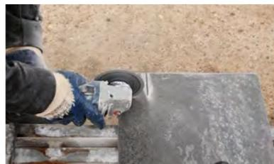
14. Cortar las placas con un disco diamantado ventilado para gres porcelánico o con un cortabaldosas en mojado.
