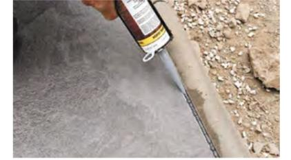
18. Si es necesario, sellar las juntas perimetrales de dilatación (mínimo 8 mm) con silicona, procurando que se adhiera a los dos lados. Las juntas de silicona generalmente requieren mantenimiento, por lo que han de ser revisadas y repasadas periódicamente.
