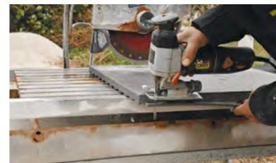
15. Cortar el material sintético a base de poliuretano con una sierra de calar con cuchilla para laminado.
